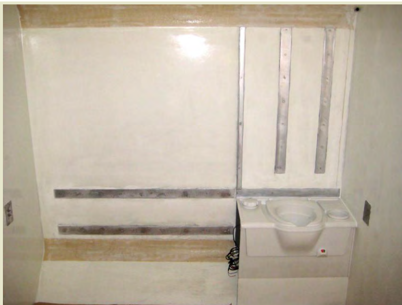
Oben: Blick ins Heck auf die laminierten Radien, Toilette und Gegenplatten der Airline-Schienen (rechtes Bild)
